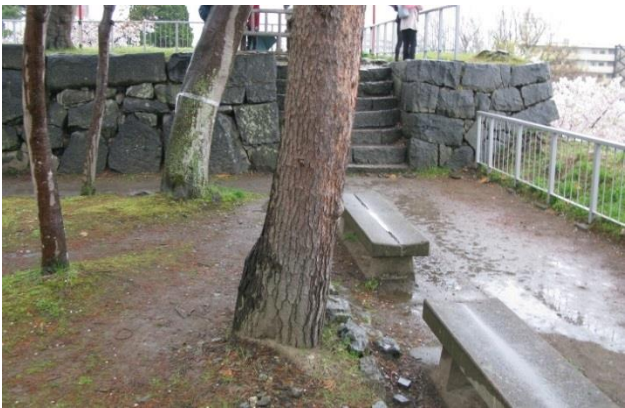
8 本丸南東アカマツの伐採前
