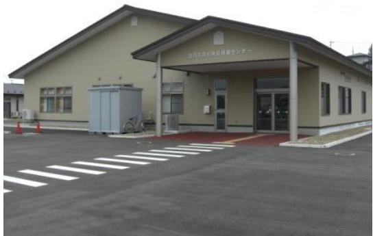
保健・福祉ゾーンの高松地区保健センター
