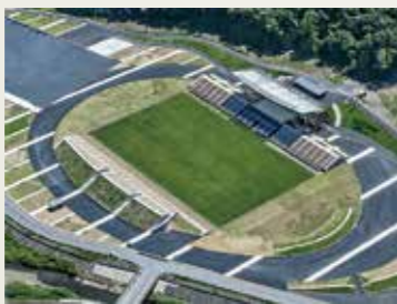
震災復興の象徴として建設された「釜石鶴住居復興スタジアム」
