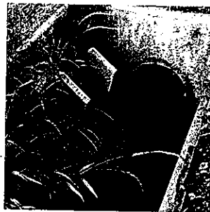
▲水が貯まらない貯水槽
