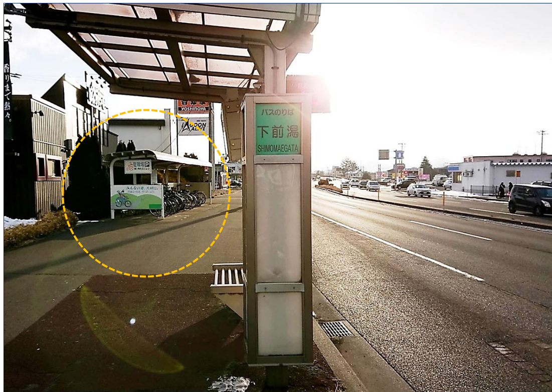
図 6-28 下前潟バス停に隣接して確保された自転車駐輪場
