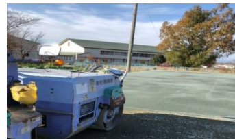
手代森下通ゲートボール場整備状況
