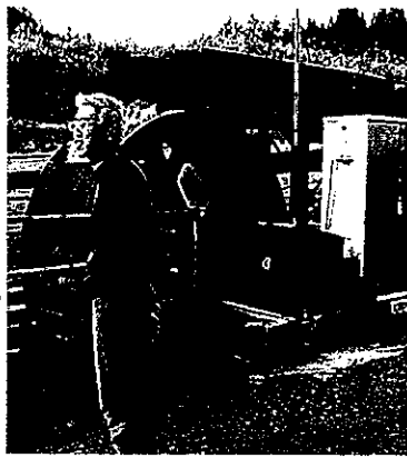
【農業用水路に設置された発電用水車】
