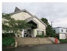
現石川啄木記念館 564.95 平方メートル 鉄筋コンクリート造
