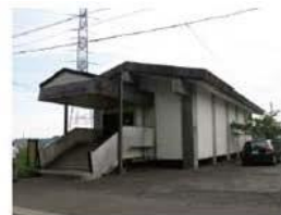
現玉山歴史民俗資料館 132.52 平方メートル 鉄筋コンクリート造
