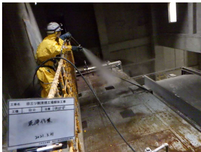
② 【ダイオキシン類除染：高圧洗浄】 実施時期：令和3年3月～5月
