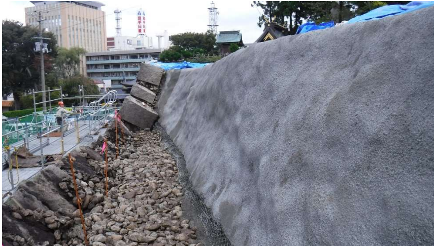
モルタル吹付後の様子
