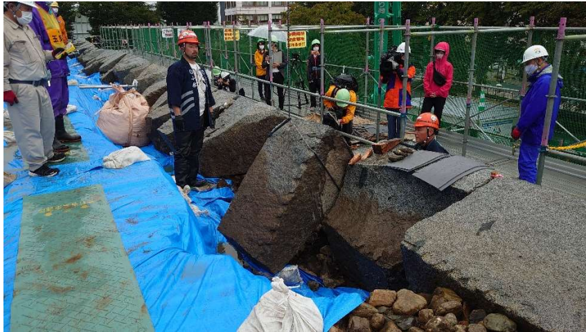
築石を持ち上げている様子
