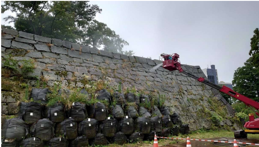
石垣洗浄作業の様子
