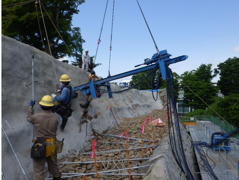
鉄筋挿入施工時の様子
