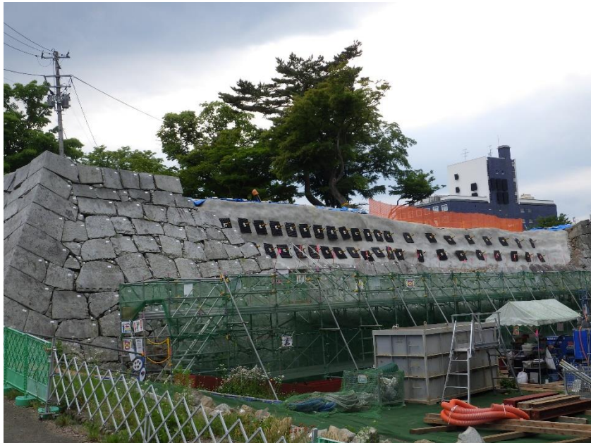
鉄筋挿入完了後の様子
