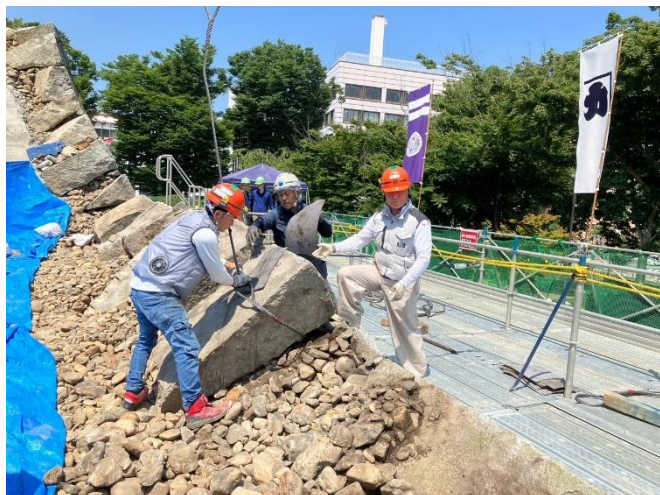
築石を大型クレーンで持ち上げる様子
