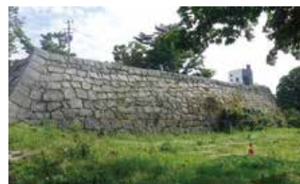
修復する石垣
