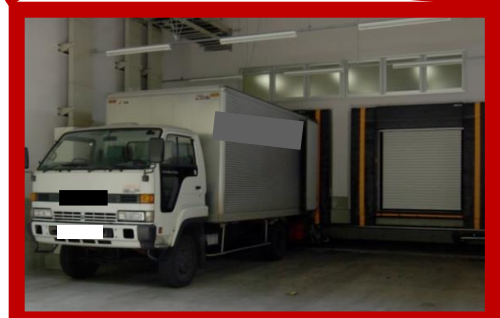
ドックシェルター（配送・回収エリア）
