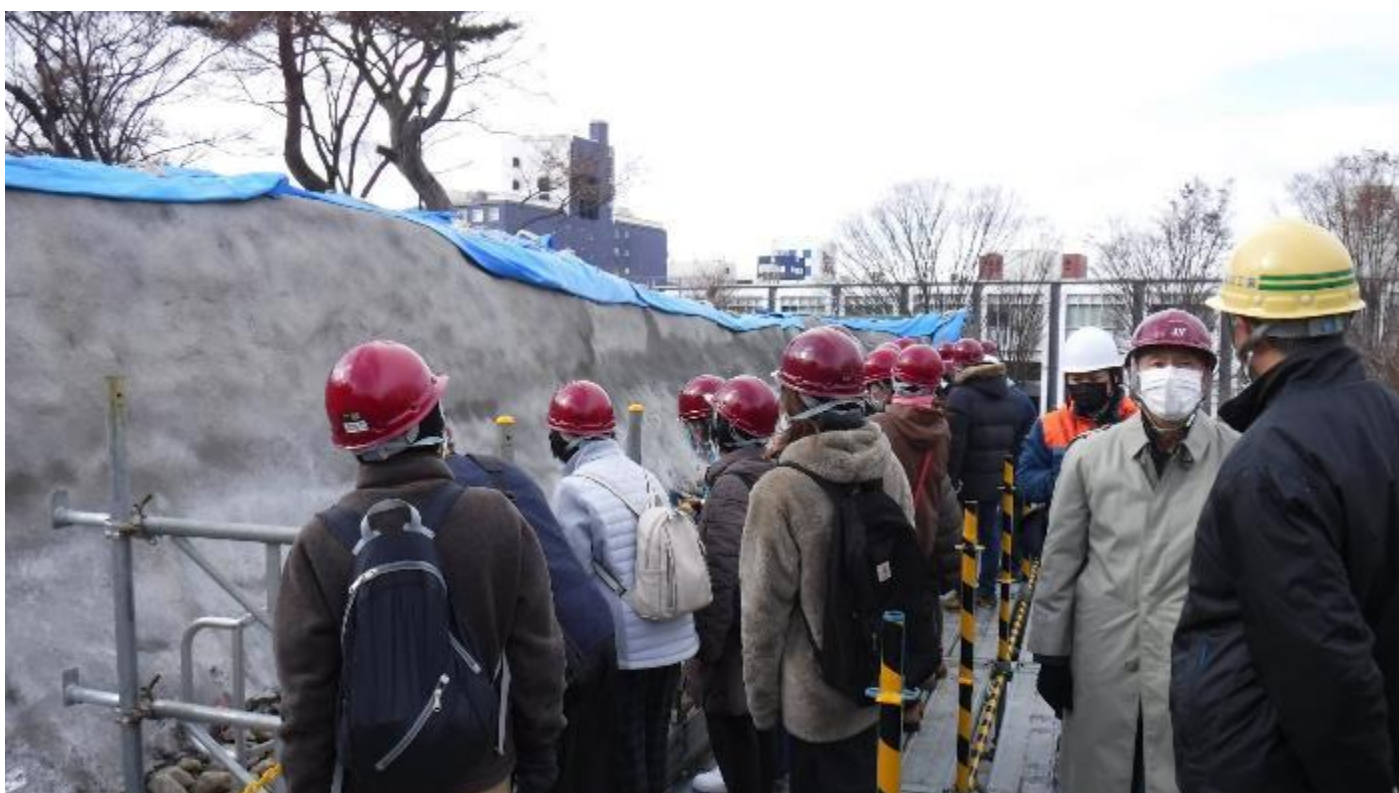
三ノ丸石垣修復現場②
