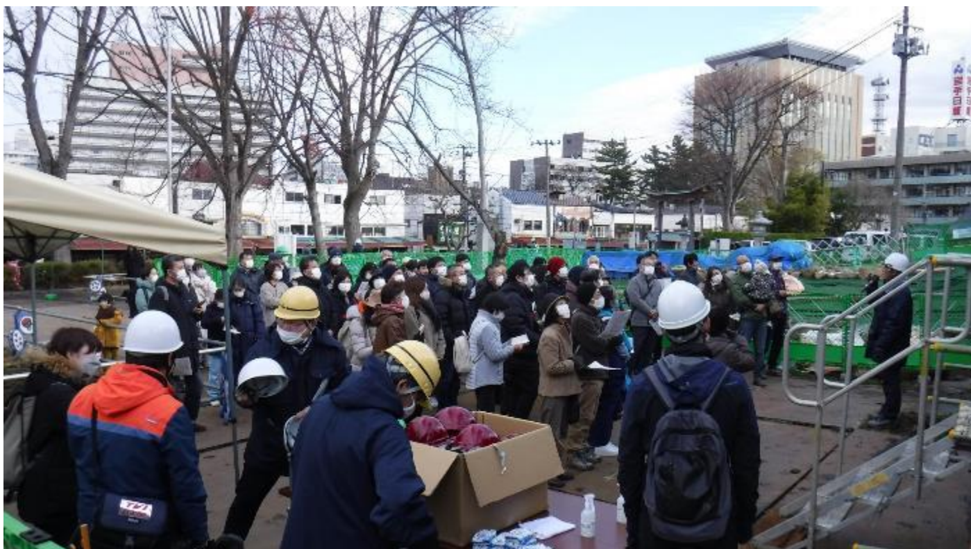
三ノ丸石垣修復現場①
