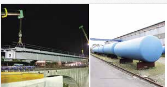
水上橋歩道橋（陸前高田市） 鋼製防火水槽
