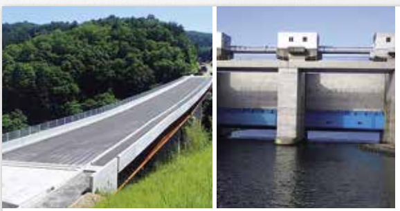
山口橋（宮古市） 下荒川水門（釜石市）
