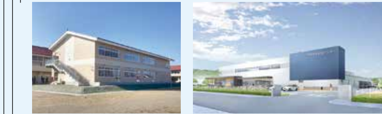
増築された飯岡小の校舎 (仮称)盛岡学校給食センターの完成イメージ
