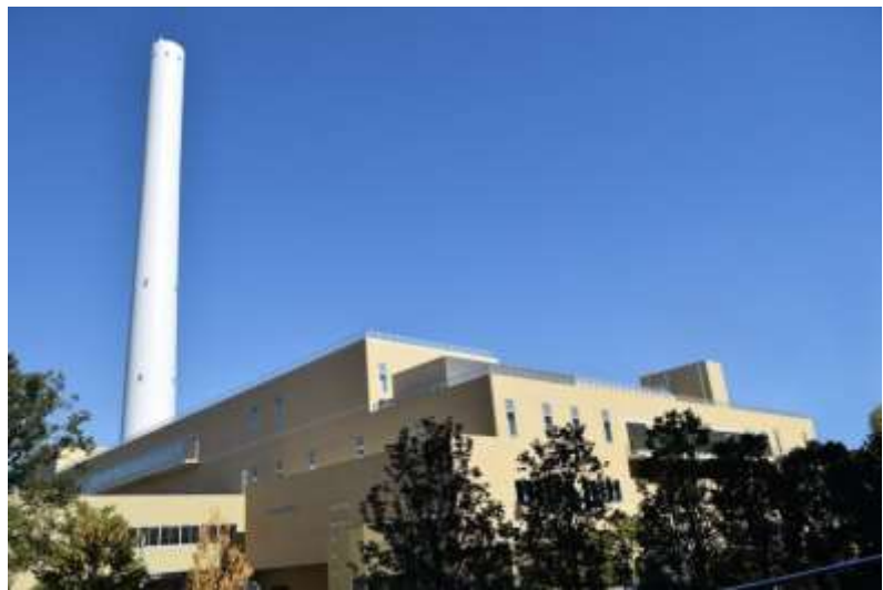
2021年竣工 処理能力 300トン/日
