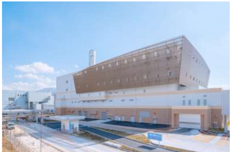
2019年竣工 処理能力 405トン/日 灰溶融炉22トン/日×2炉
