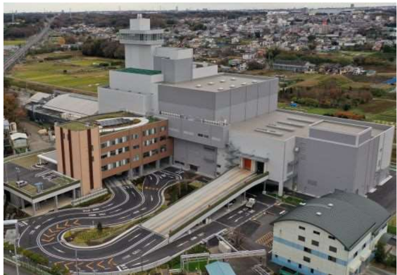
2019年竣工 処理能力 245トン/日
