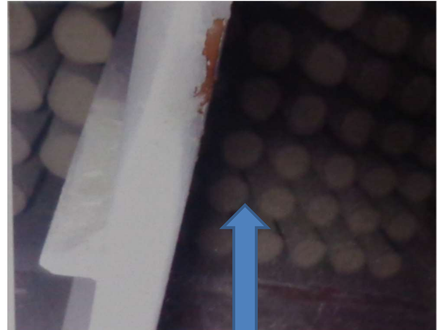
出典:高座クリーンセンター 見学パネル
