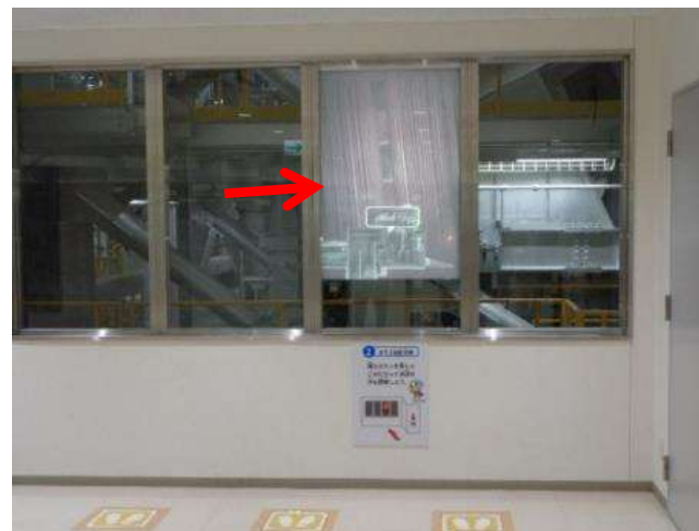
ガラス投影装置 ・ ごみの主観でストーカ炉の説明映像が見られる。
