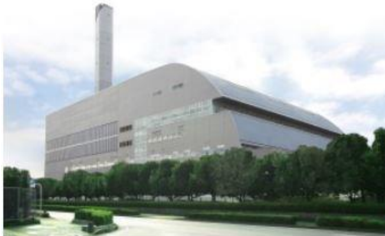
2010年竣工 処理能力 525トン/日
