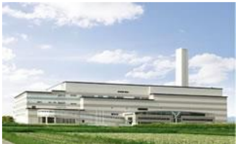
2005年竣工 処理能力 600トン/日
