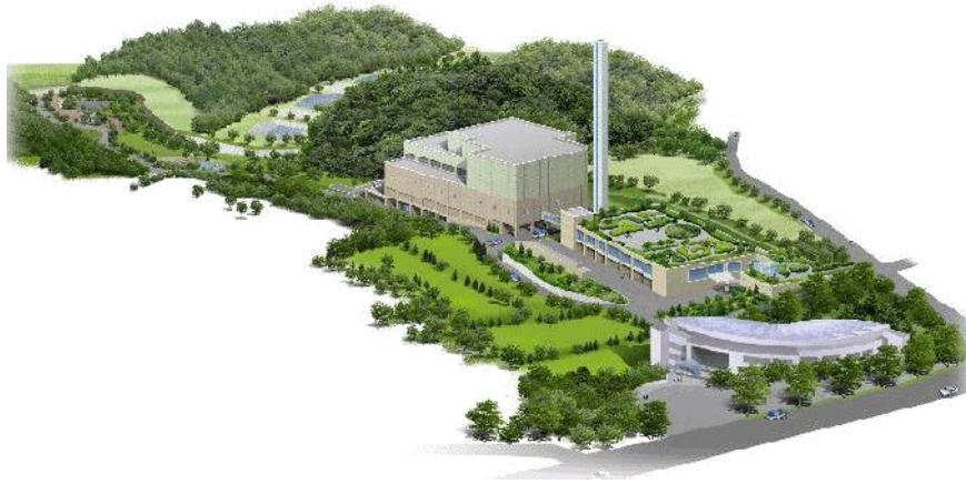
2012年竣工 処理能力 450トン/日
