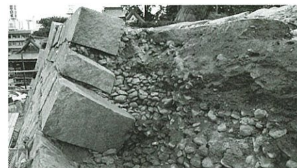
石垣内部状況
