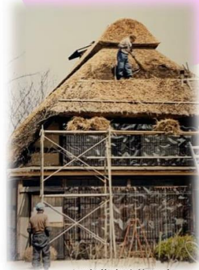
旧齊藤家改修工事
