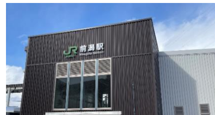
■前潟駅外観（工事中）
