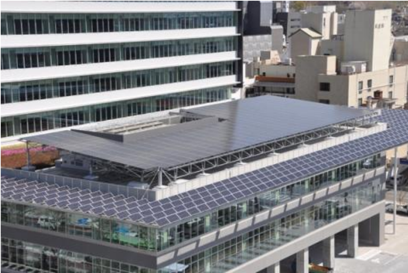
(屋上太陽光発電 出典：甲府市公式HP)
