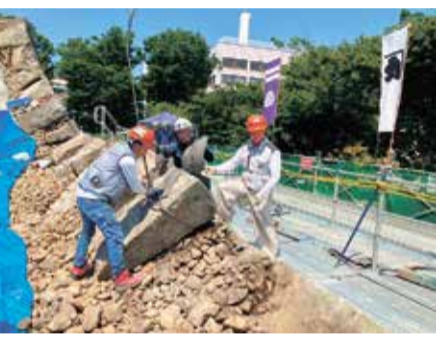
修復作業の様子▶
