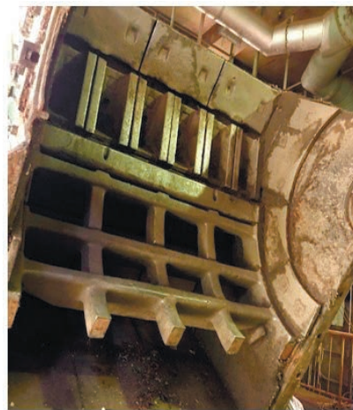
修繕が行われるグレートバー
