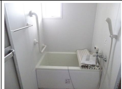
住戸内 浴室(改善済み)
