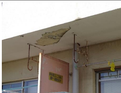
南面外壁 ベランダ天井
