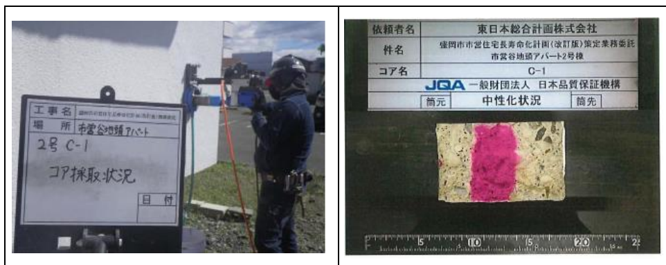
試験体の採取・中性化状況
