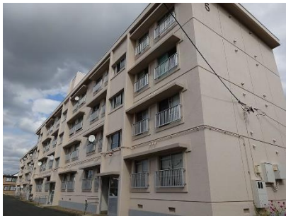
北面外壁 問題なし
