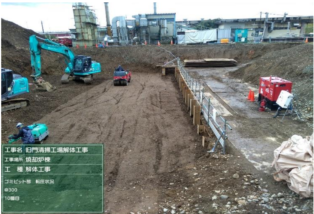
埋戻し(ごみピット跡地)
