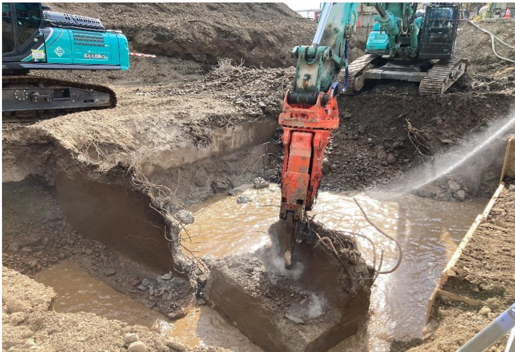
焼却炉棟 地下部解体(ごみピット)
