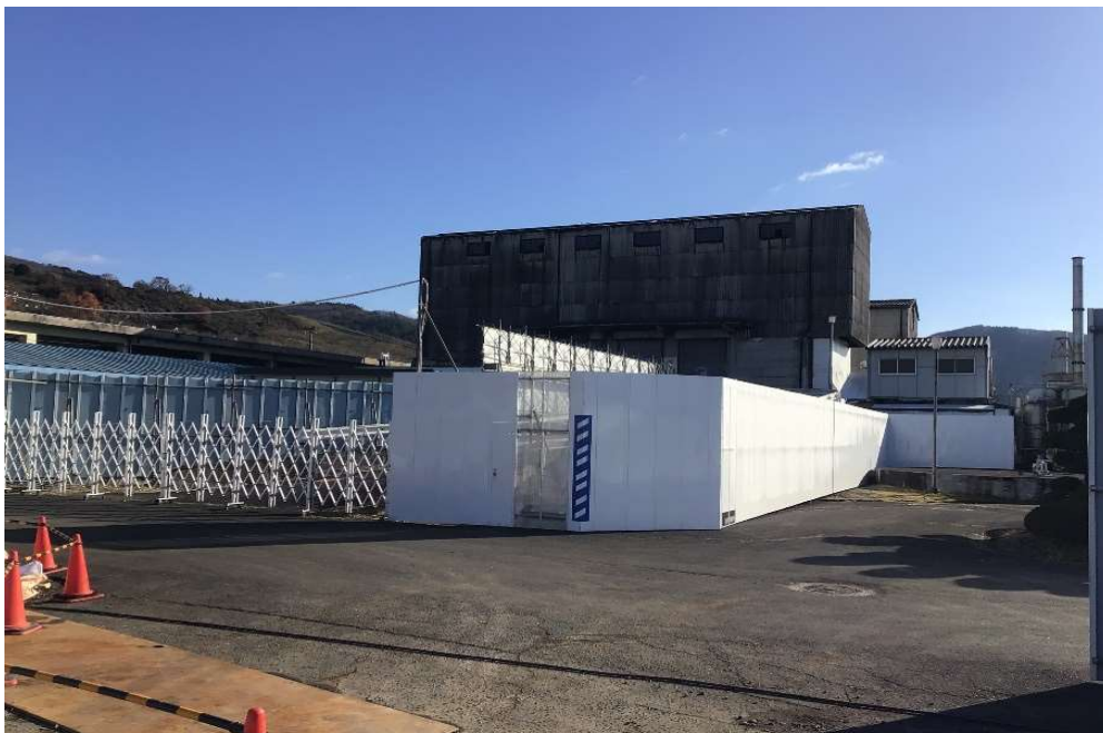
仮囲い設置完了(北西側)
