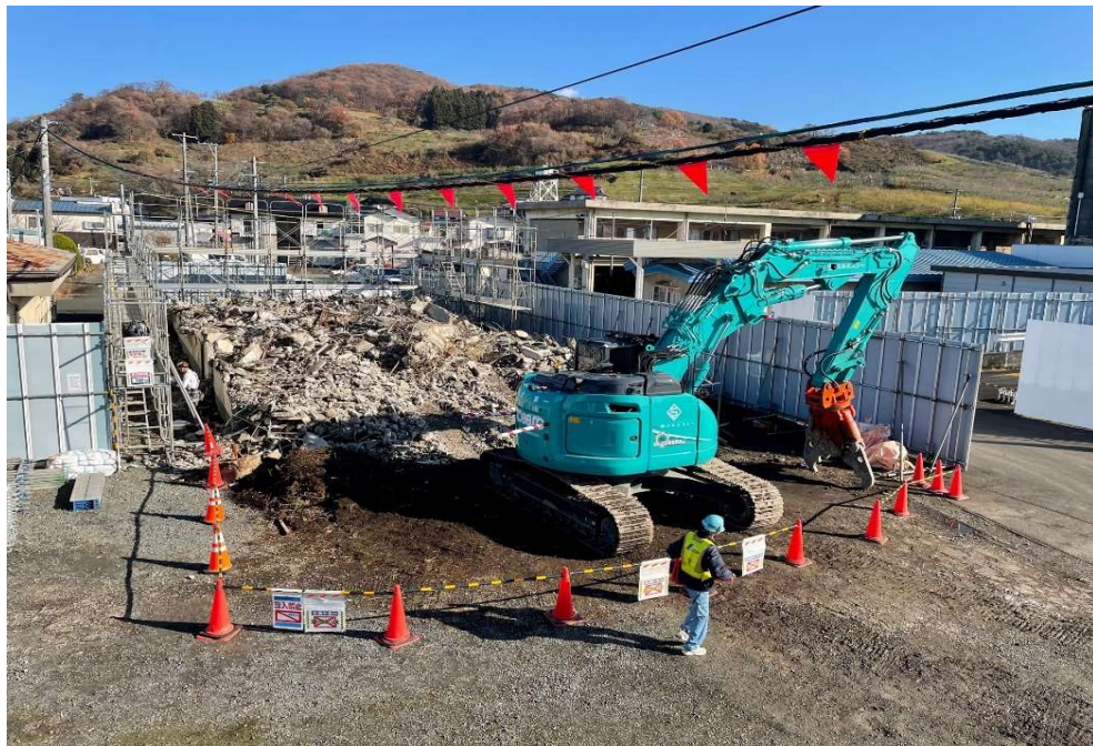
管理事務所解体状況
