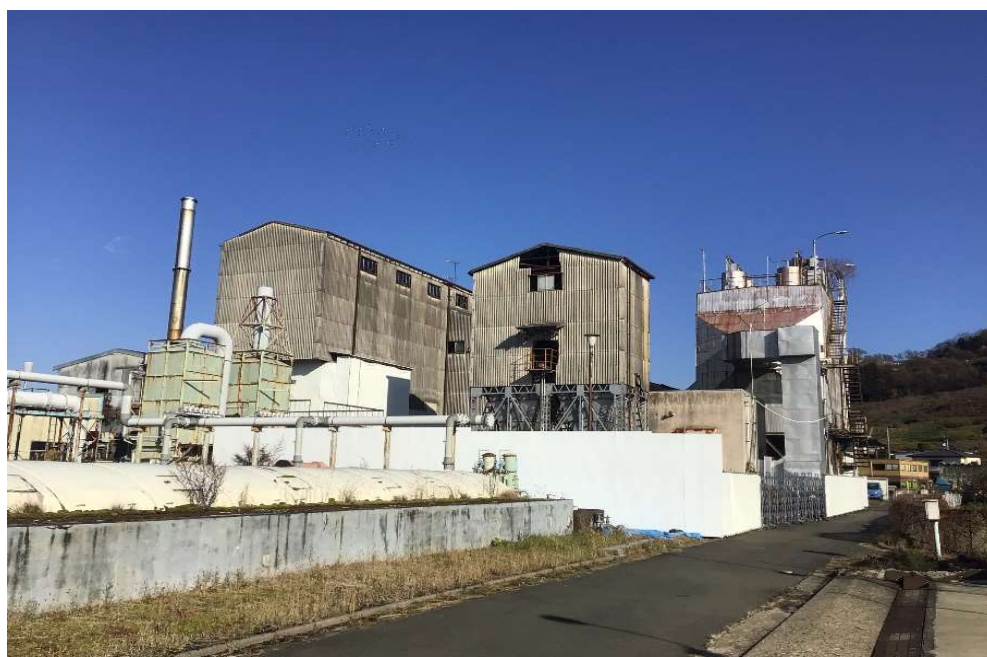
仮囲い設置完了(南西側)
