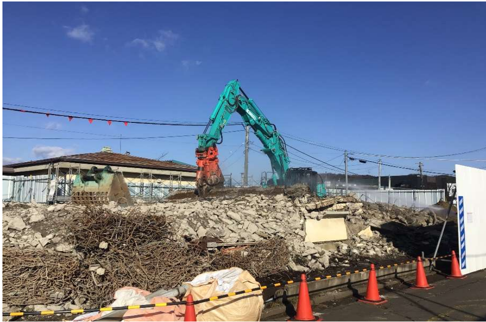
管理事務所解体状況
