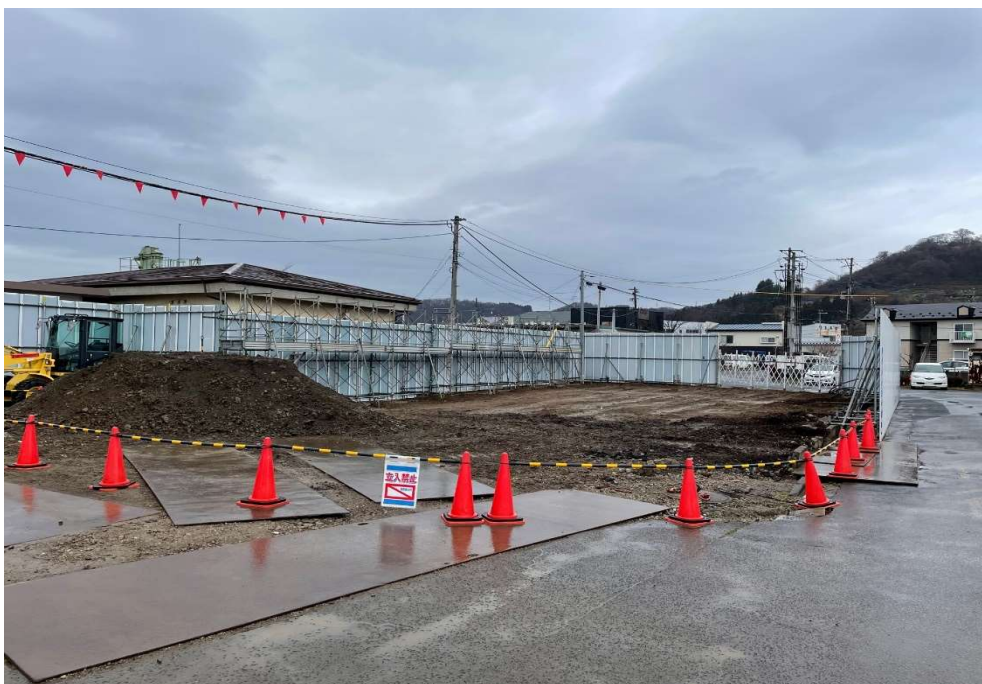
管理事務所解体完了
