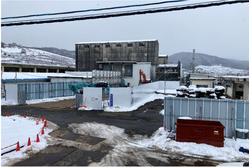
スロープ解体完了
