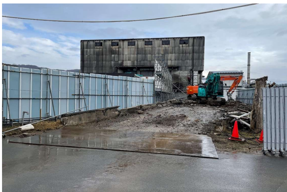
スロープ解体状況
