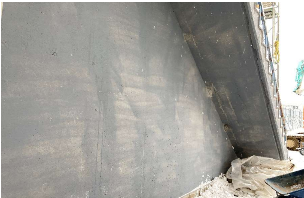
排水処理施設 石綿除去完了
