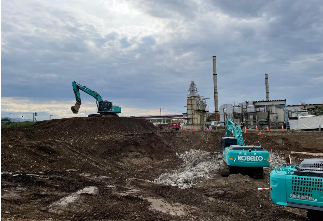
焼却炉棟 地下部解体③
