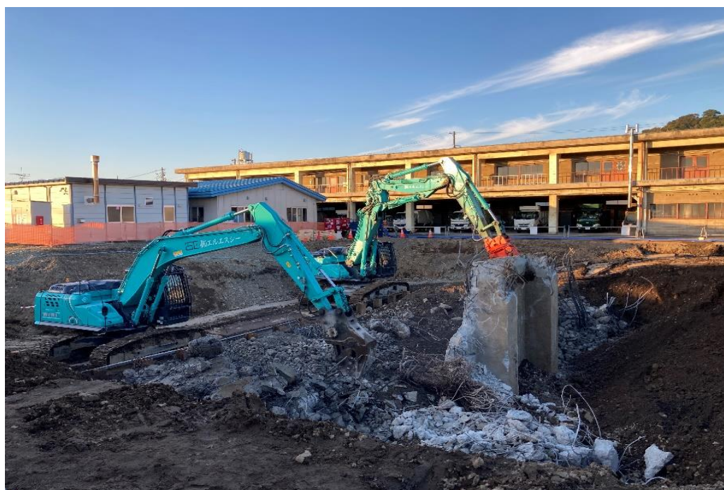
焼却炉棟 地下部解体②
