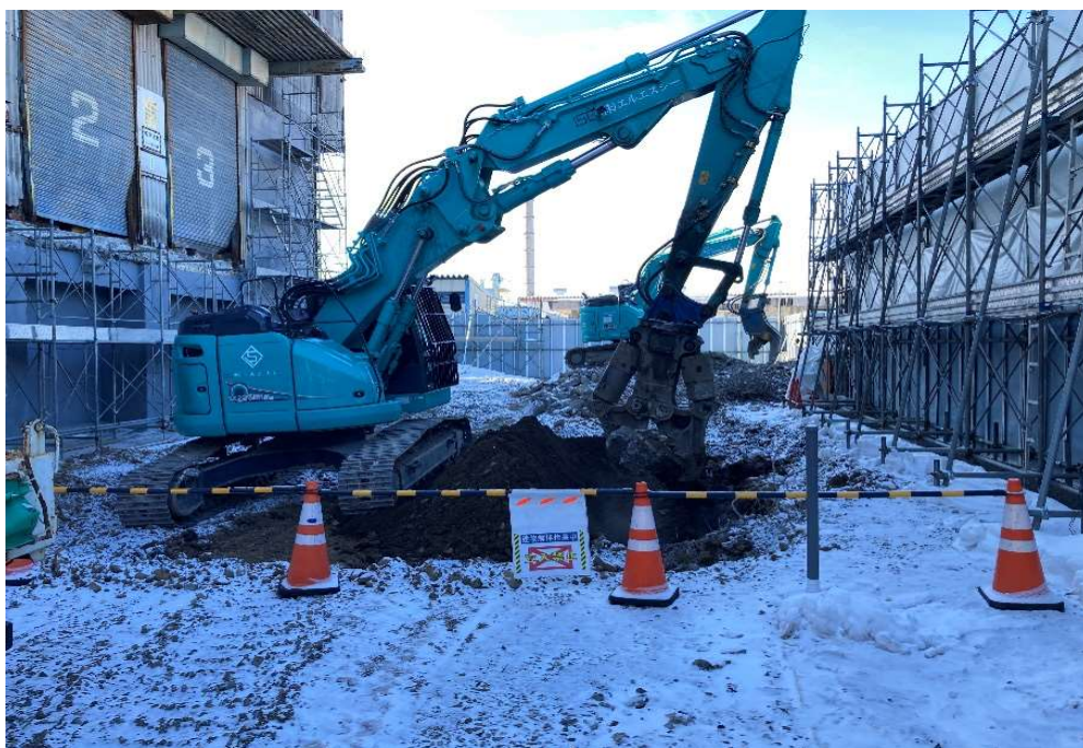
プラットフォーム 基礎解体状況
