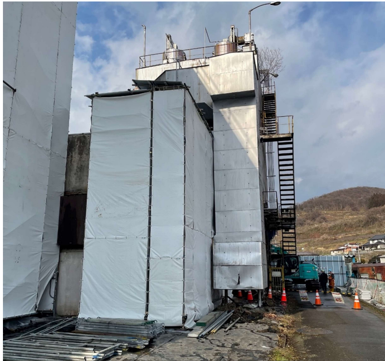
誘引送風機室 石綿除去足場養生完了
