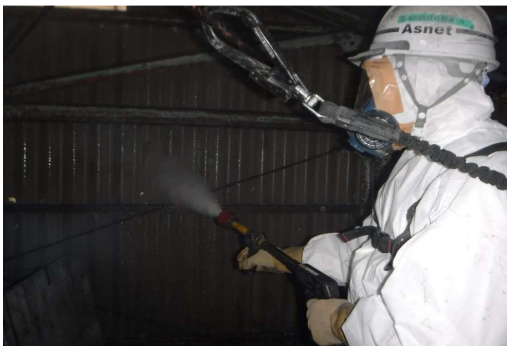
灰出バンカ 除染状況
