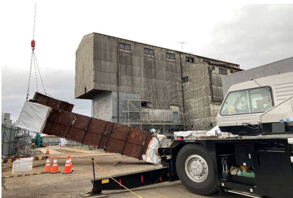
誘引送風機室 煙道撤去状況
