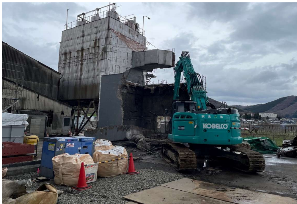
誘引送風機室 解体状況
