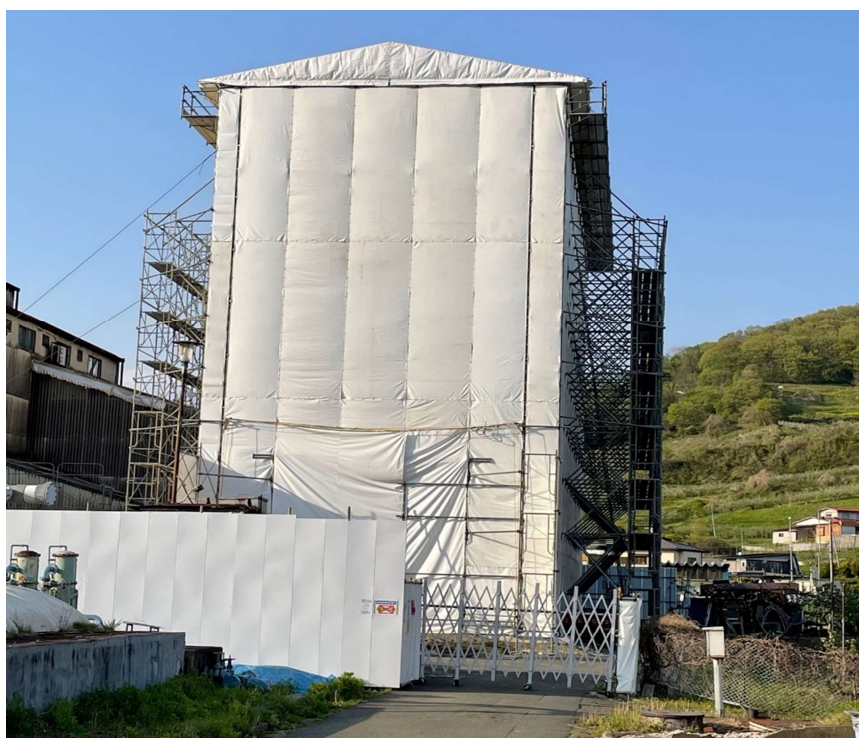
電気集塵機 除染用足場組立養生完了
