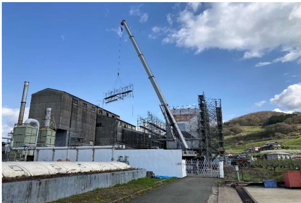
電気集塵機 除染用足場組立状況
