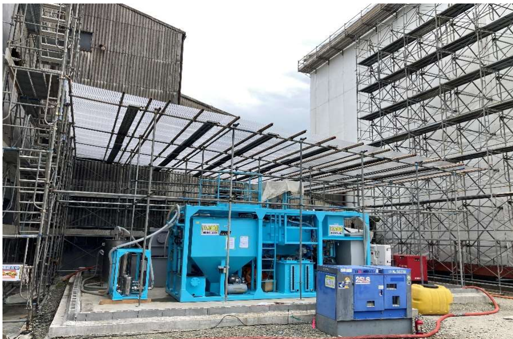
除染用 循環利用施設設置
