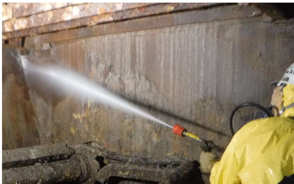
電気集塵機 除染状況
