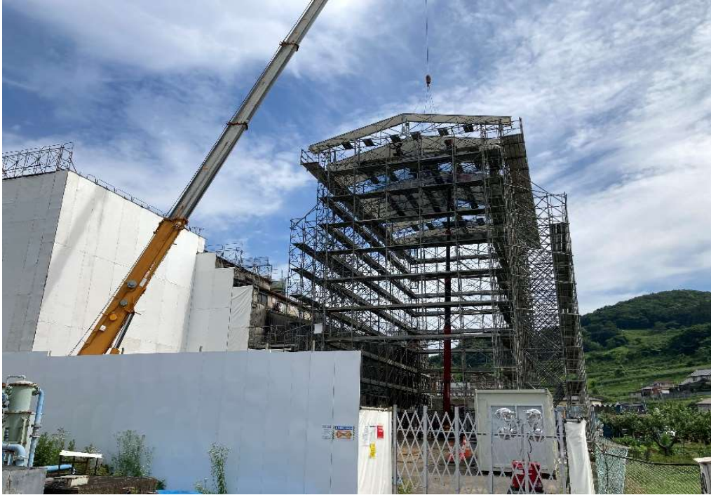
電気集塵機 養生足場解体状況
