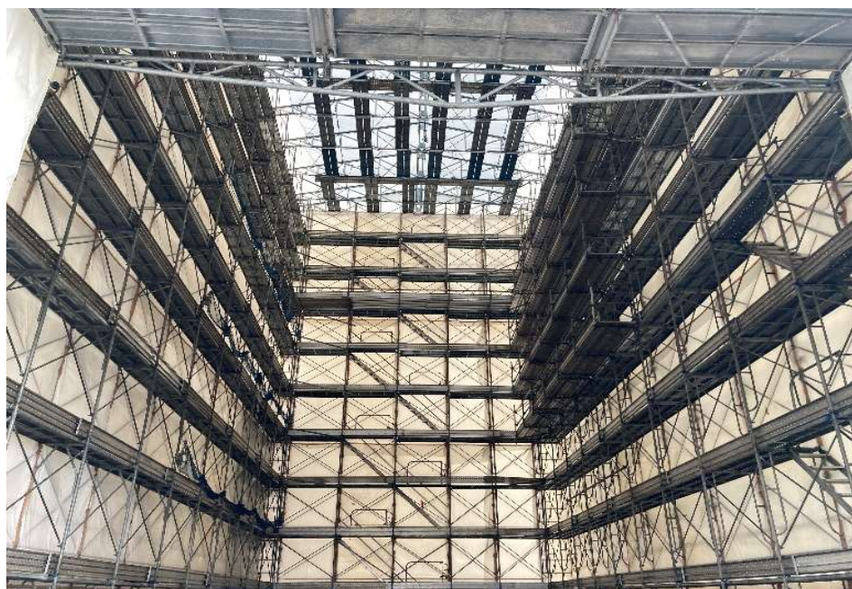
電気集塵機 解体完了
