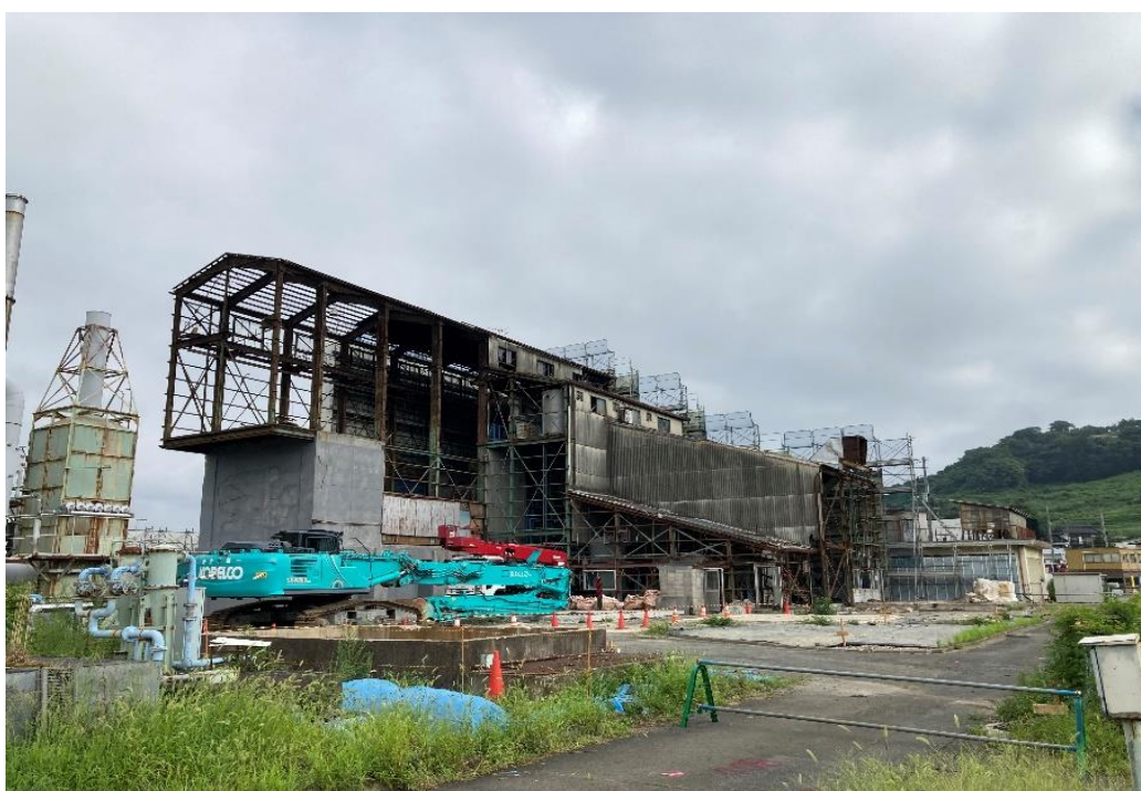
全景 南西面より撮影
