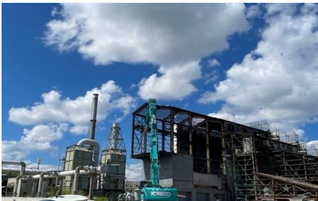
焼却炉棟 一部解体
