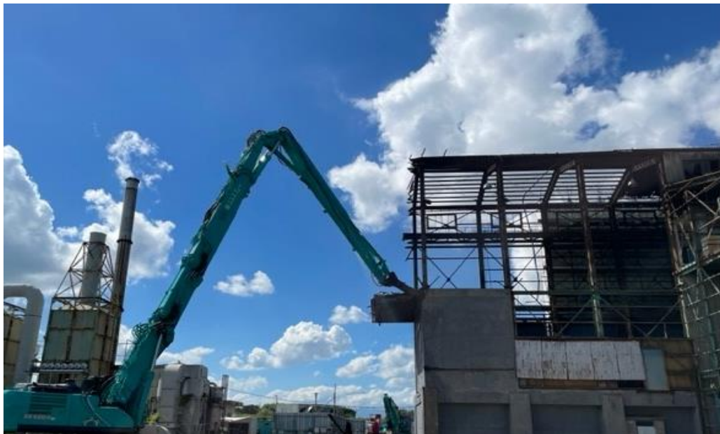
焼却炉棟 一部解体
