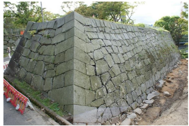
根石押え石（三ノ丸北西部）
