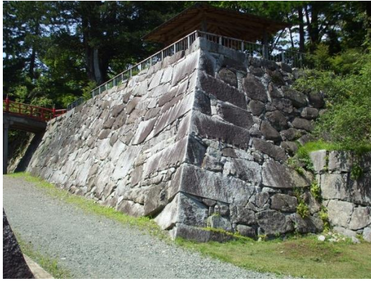
⑨乱積C ニノ丸南東部（隅部分）
