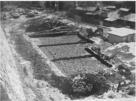
米内蔵基礎地業（淡路丸下南部）
