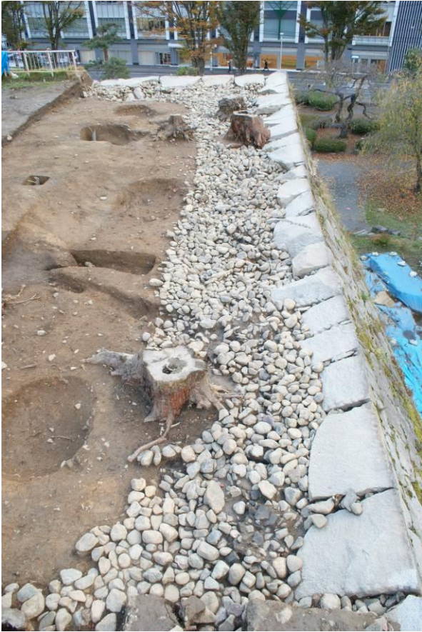
石垣天端・栗石（三ノ丸北西部）
