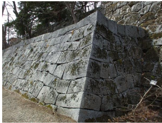
⑲布積D 二ノ丸東側ハバキ石垣
