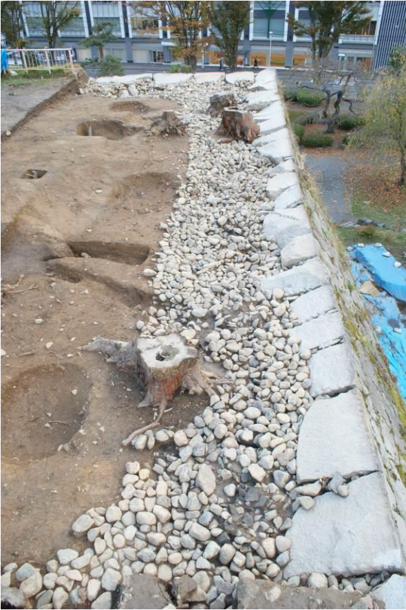
石垣天端・栗石（三ノ丸北西部）
