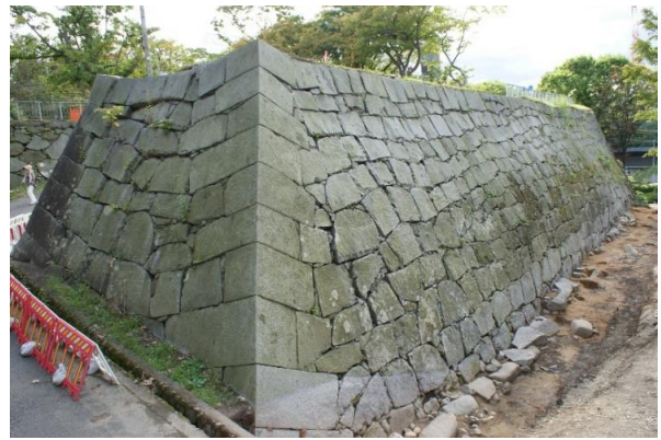
根石押え石 (三ノ丸北西部)
