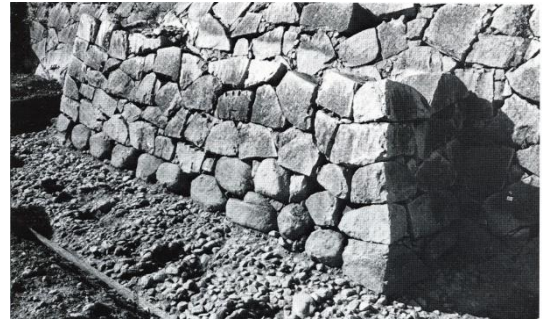
⑱布積C 淡路丸ハバキ石垣（撤去前）
