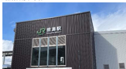
■前潟駅外観（工事中）
