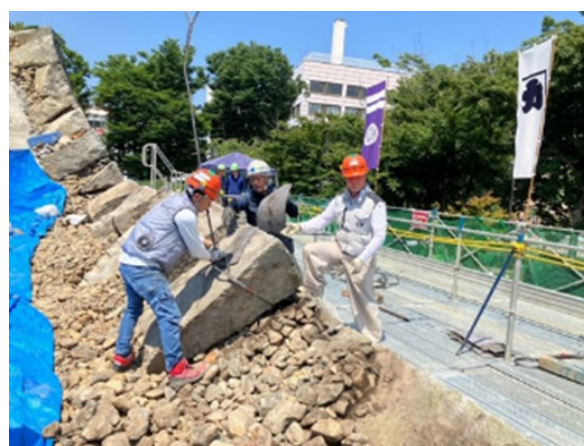
昨年度の石垣解体の様子
