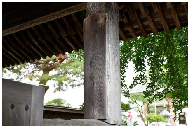
北側控柱に取付けられた棟札 1
