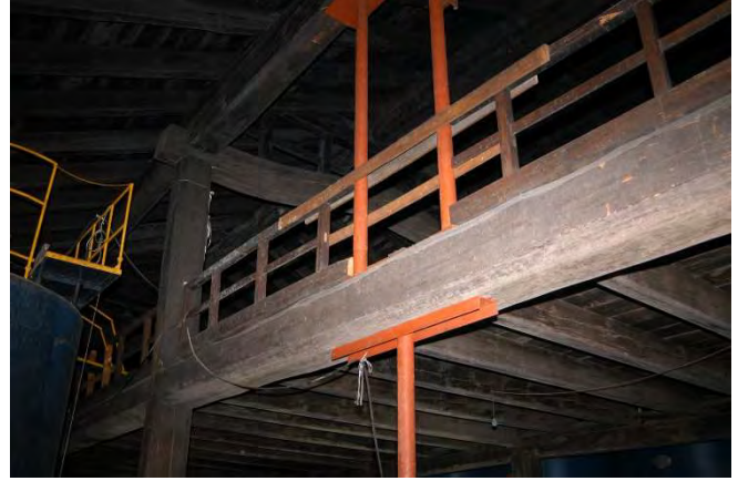
改修前（平成18年）の二階手摺
