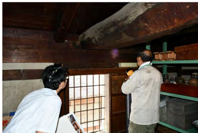
内部調査の様子
