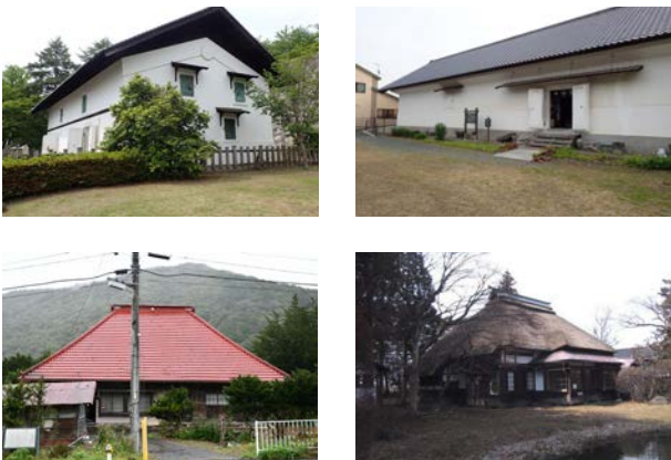
Fig.VI.1 (写真左上から時計回りに) 彦御蔵、御蔵（明治橋際の御蔵）、原敬生家、新谷番所跡
