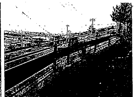
フェンス改修 〔手代森〕
