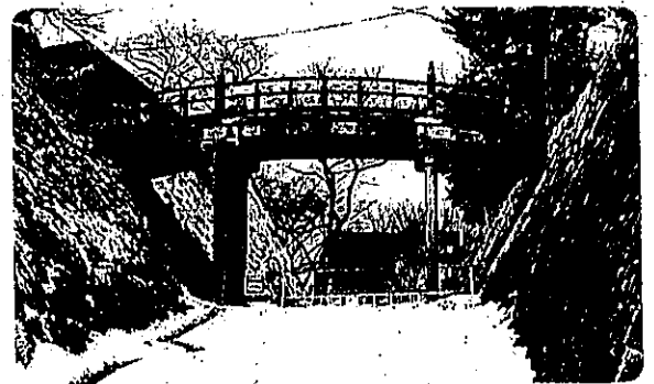
盛岡城跡公園廊下橋
