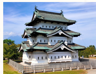
石垣修復工事で曳家された本丸天守
