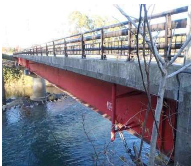
鋼橋 (例：鶴飼橋)
