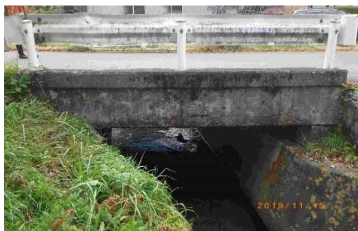
RC 橋 (例：城内線 3 号橋)
