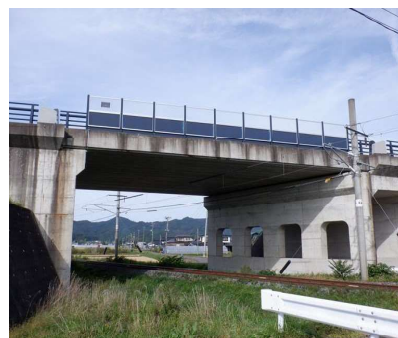
PC 橋 (例：谷地跨線橋)
