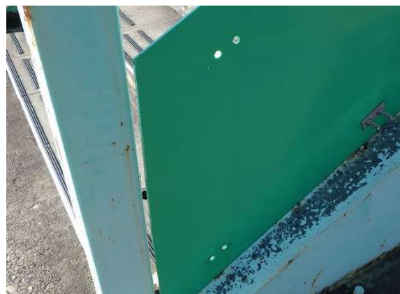
(ボルトの脱落 [高欄部])
