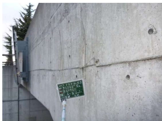
(コンクリートのひびわれ)
