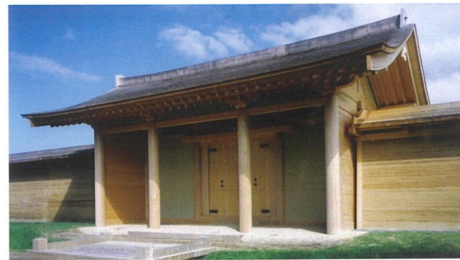
復元された志波城跡政庁南門（八脚門）
