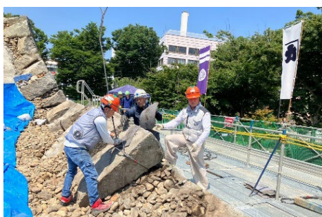
石垣解体の様子
